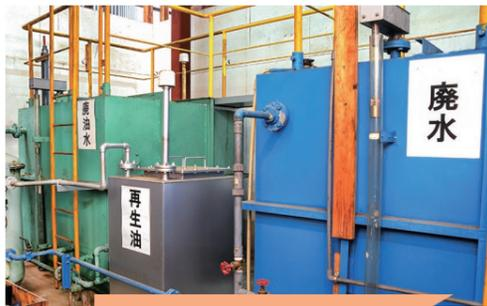
“ 廃油は、中間処理「油水分離」により廃油を回収します。
